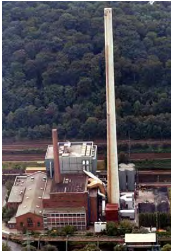
Bild 12.1.1.1-2: Luftbild des HKW Elberfeld [STAAB, 2005]
