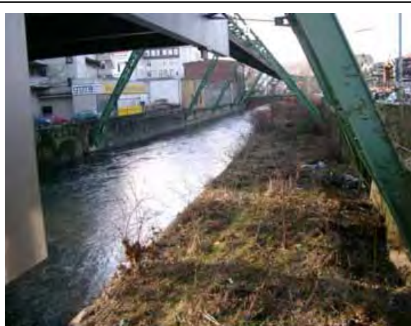
Bild 17.3.1-2: Unter der Adlerbrücke
