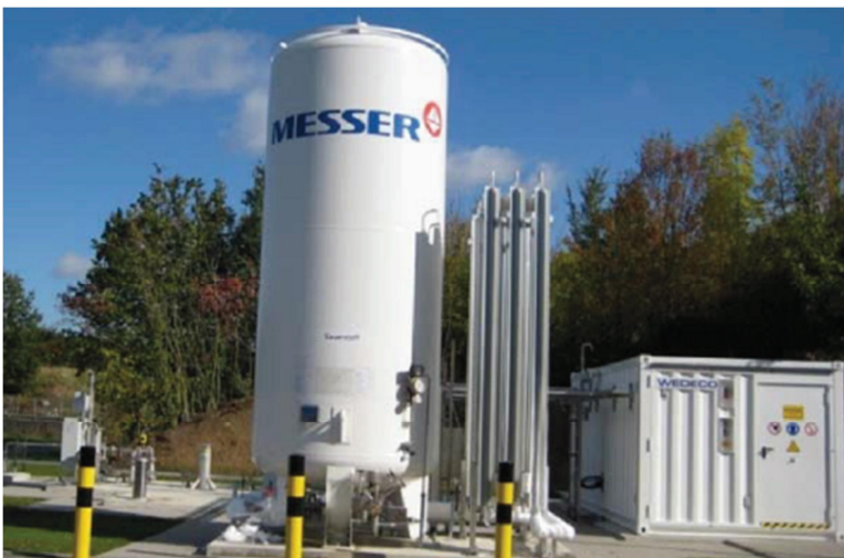
Bild 2.14: Sauerstofftank und Ozongenerator der KA Bad Sassendorf (Lyko, 2013)
