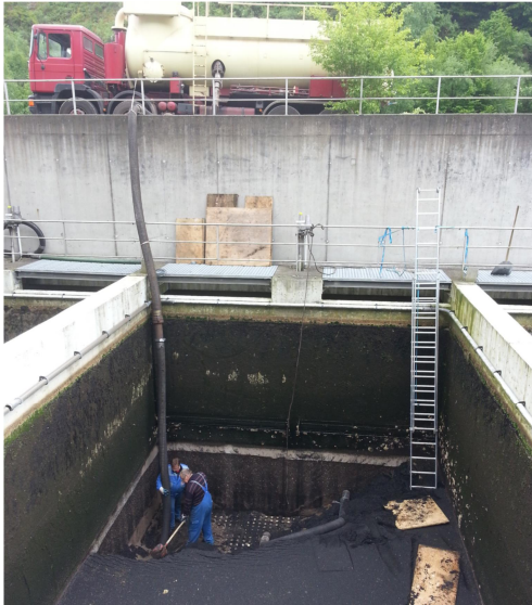
Bild 2.8: GAK als Ersatz für konventionelles Filtermaterial (Kolisch et al., 2014)
