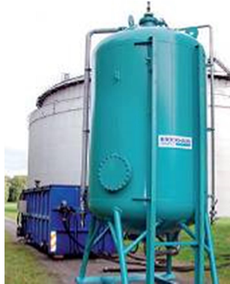
Bild 2.9: GAK als separater Druckfilter (Herbst et al., 2013)
