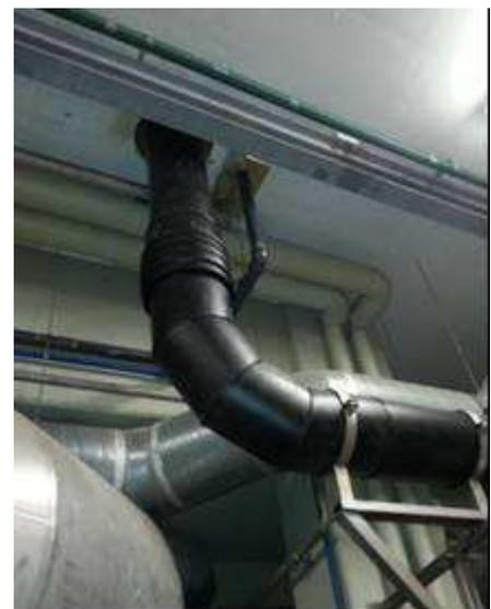
**Bild 3.14: Deckendurchführung der Beschickungsleitung zum nGAK-Filter**
