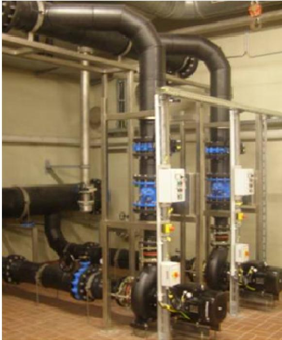
**Bild 3.13: Installierte Kreiselpumpen zur Beschickung des nGAK-Filters**
