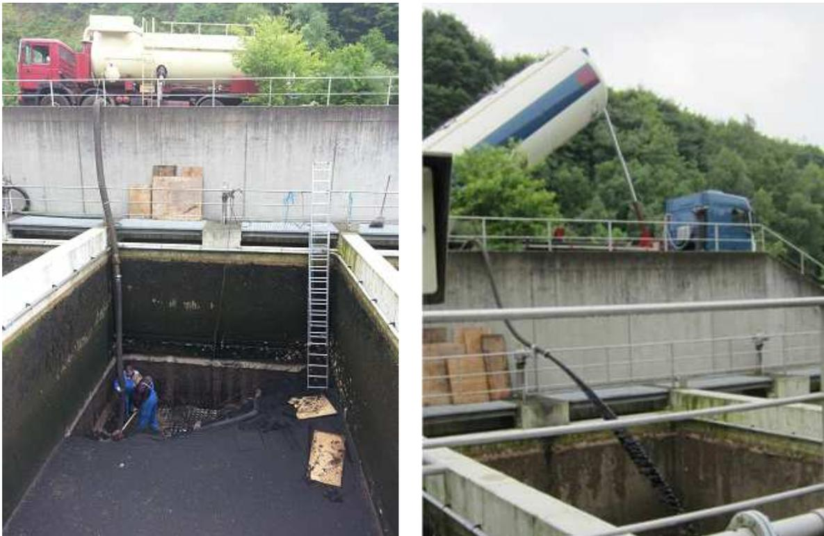
**Bild 3.11: Entleerung und Neubefüllung einer Filterkammer: altes Filtermaterial wird abgesaugt (links), GAK mit Wasser eingespült (rechts)**
