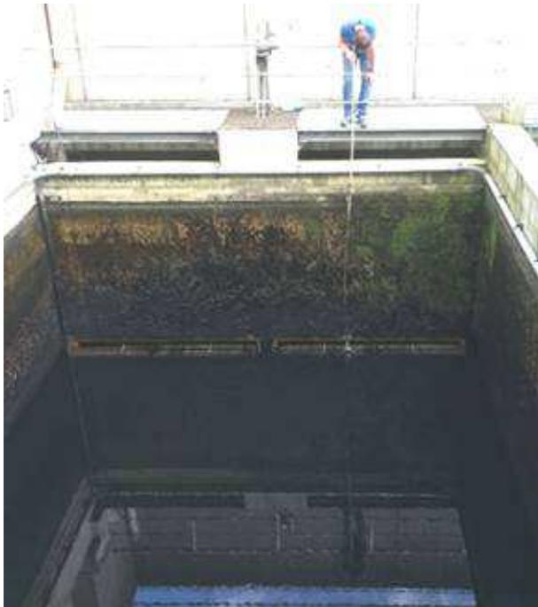
**Bild 3.18: Nachspülung (voll geöffnete Schlammwasserklappe)**
