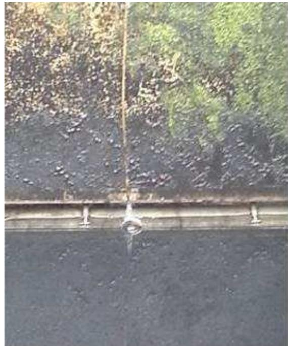
**Bild 3.19: Kontrolle des Materialverlustes über Schlammwasserklappe während der Nachspülung**
