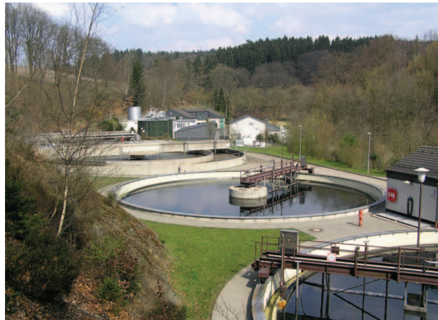
links: im Vordergrund die Nachklärbecken, links dahinter das Belebungsbecken, dahinter Eindicker (siehe auch unten) und weitere Anlagenteile
