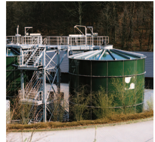
links: im Vordergrund die Nachklärbecken, links dahinter das Belebungsbecken, dahinter Eindicker (siehe auch unten) und weitere Anlagenteile
