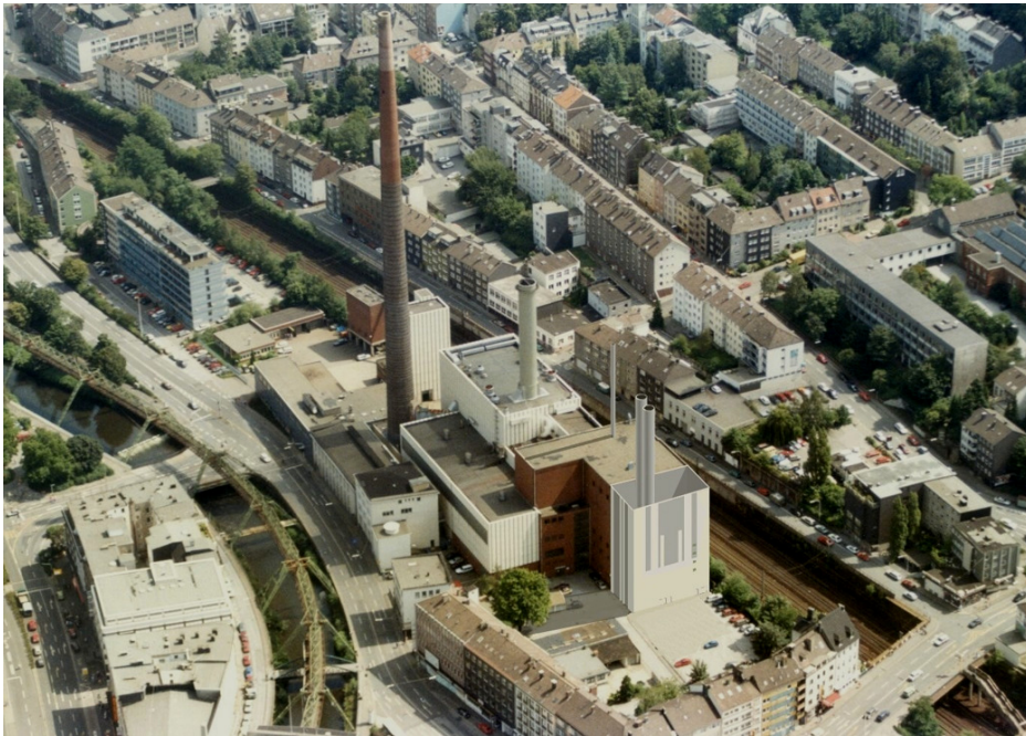
Bild 17.2.1-3: HKW Barmen in räumlicher Lage zwischen Bahntrasse, Wupper und städtischen Verkehrswegen bzw. Wohnbebauung [STAAB, 2005]
