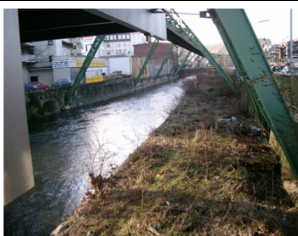
Bild 17.3.1-2: Unter der Adlerbrücke
