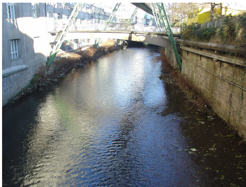
Bild 17.3-1: Technisch ausgebauter Wupperabschnitt mit Ufermauern im innerstädtischen Bereich von Wuppertal
