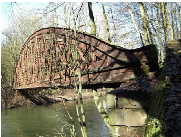
Die alte Straßenbahnbrücke in Müngsten (Foto: August Scheidtmann)
