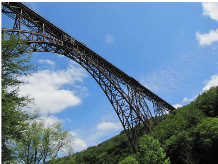
Beeindruckendes Bauwerk: die Müngstener Brücke (Foto: Wupperverband)
