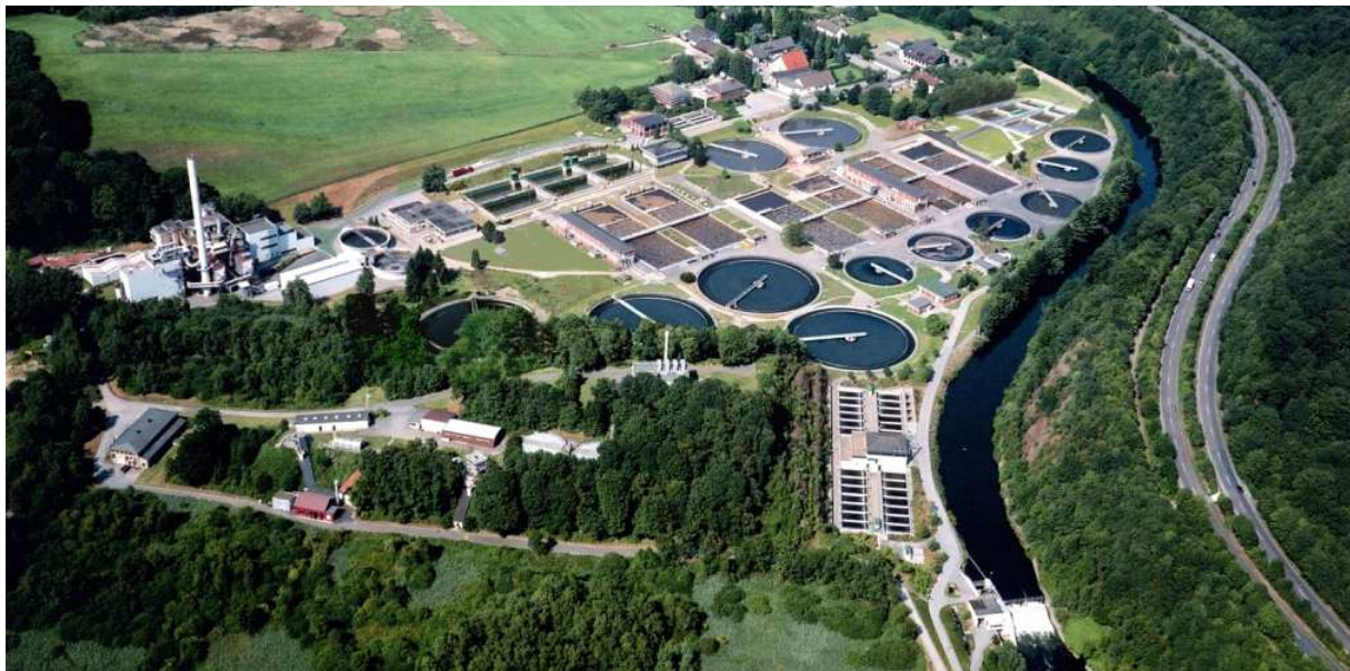
Bild 2.1: Kläranlage Buchenhofen mit Flockungsfiltration im Vordergrund
