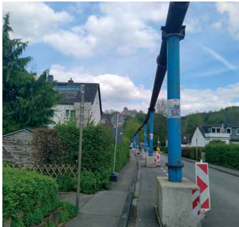
Abwasserüberleitung in Solingen Unterburg
