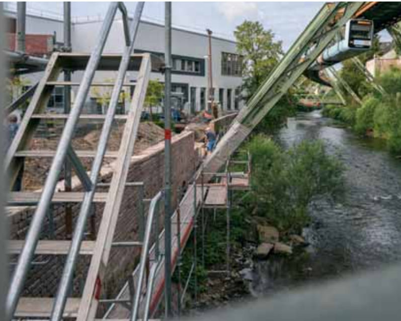
Sanierung der Ufermauern
