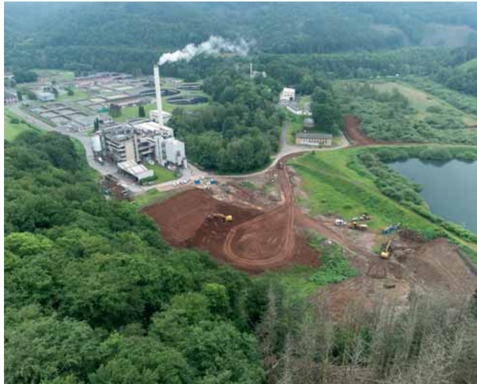
Buchenhofen: hinten links die Kläranlage, davor die Schlammverbrennungsanlage, vorne das neue Baufeld, rechts die Schlamm Lagerflächen
