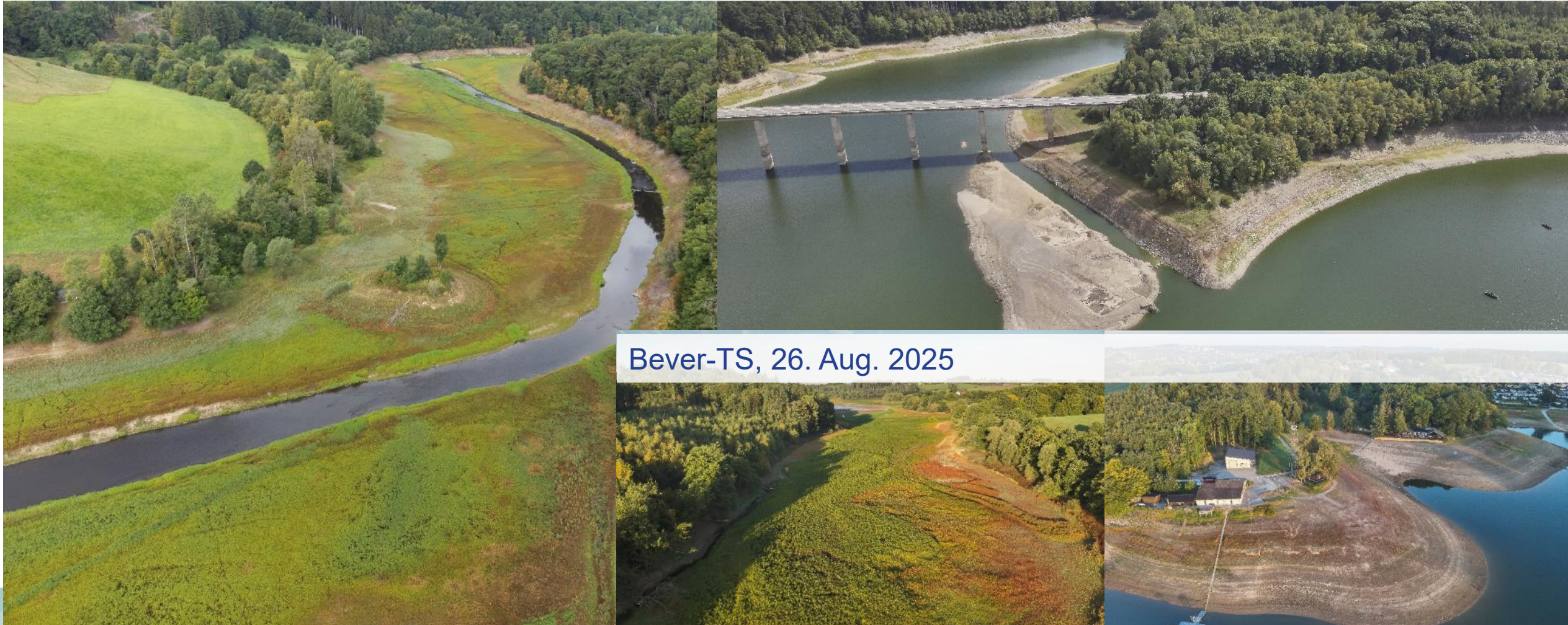
Wupper-TS, 26. Aug. 2025, Karrenstein & Nähe Absperrbauwerk
