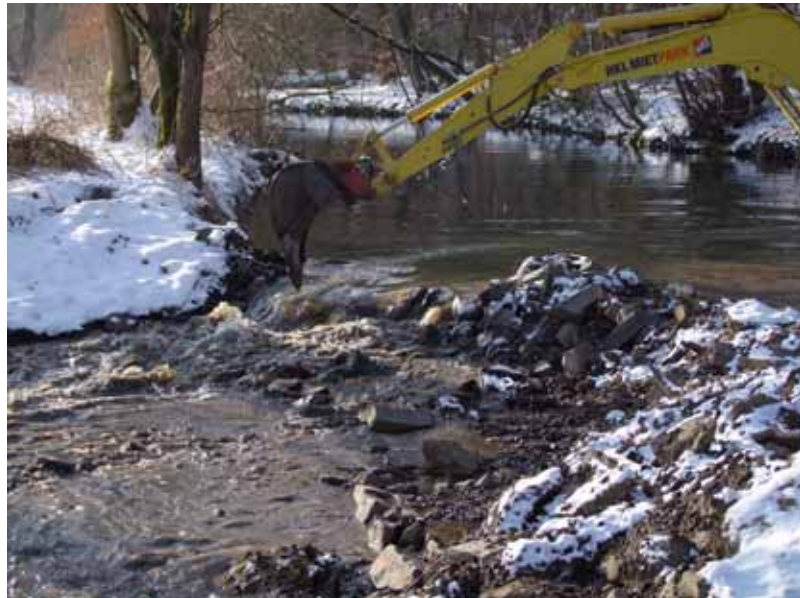
Umlegung der Dhünn in das neue durchgängige Gerinne (links) am 17.02.2010
